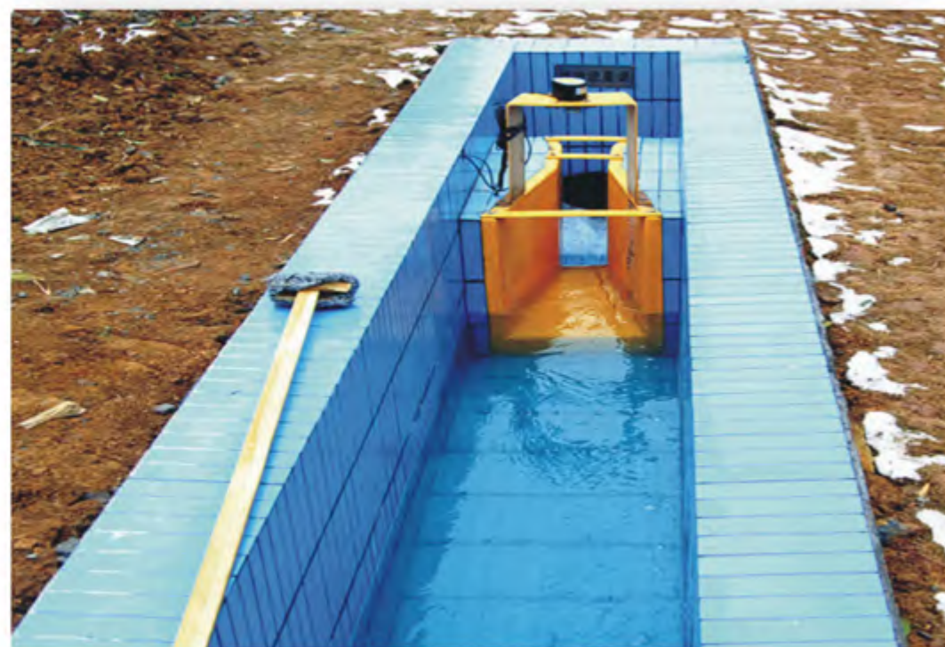
黑山谷污水处理站排放渠图片
