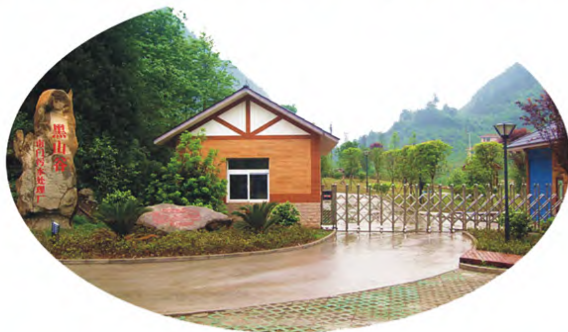
黑山谷污水处理工程进场图片
